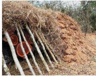
Figura 34c. Cobertura do forno com capim e terra compactada sobre a camisa (cintura de estacas escoreando a pira). Djabula, foto F. Zacarias (2021)
