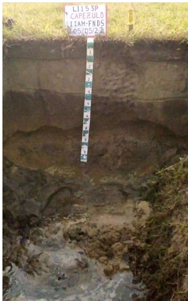
Foto 10: Solo arenoso hidromórfico (depressões e linhas de drenagem natural).
